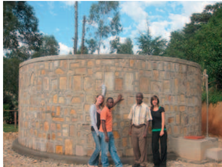
Zisterne in Kirinda, 2008 in Betrieb genommen
