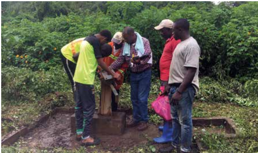
Untersuchung einer beschädigten Pumpe in der Tikar-Region durch HITIP
