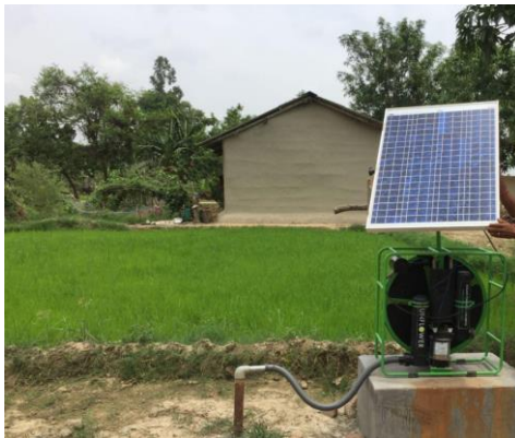
Bild 1: Aufgabenstellung der Challenge 2021/2022: Wie lassen sich freie Kapazitäten von solarbetriebenen Wasserpumpen in Nepal am besten nutzen?
